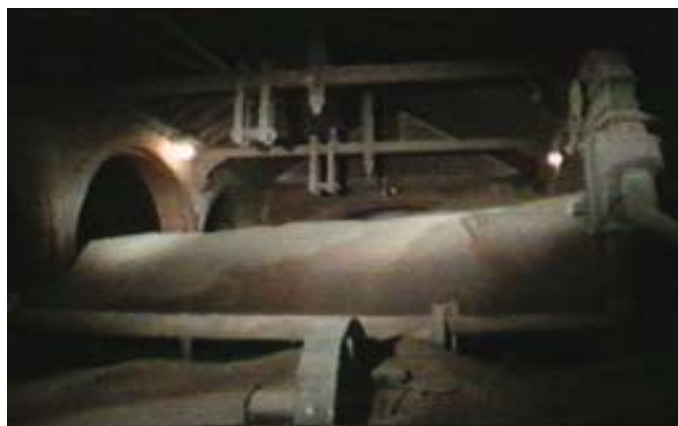
Getreide fast bis zum Dach. Blickrichtung von der Orgelempore zum Altarraum
